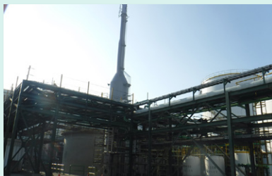
▲燃燒塔母火燃料替換
